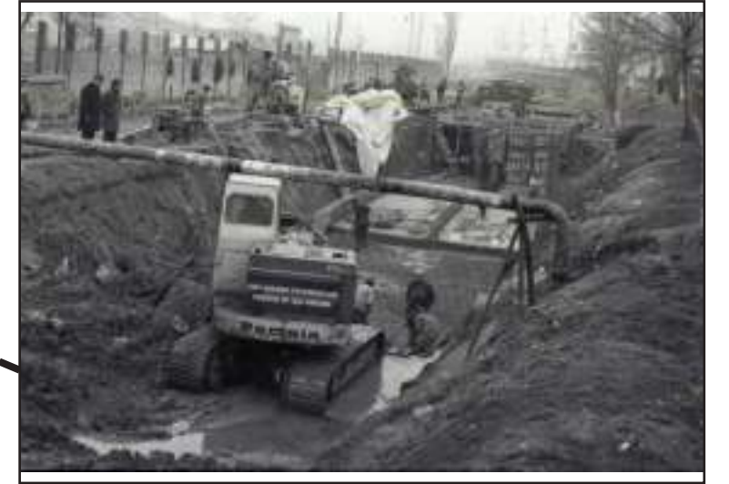
İncesu Deresi kapatılma çalışmaları.
